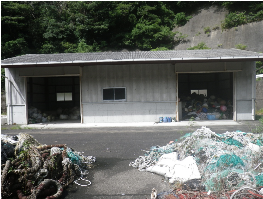
【ストックヤード（倉庫）全景】
