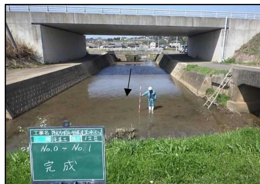
浚渫が完了した河川
