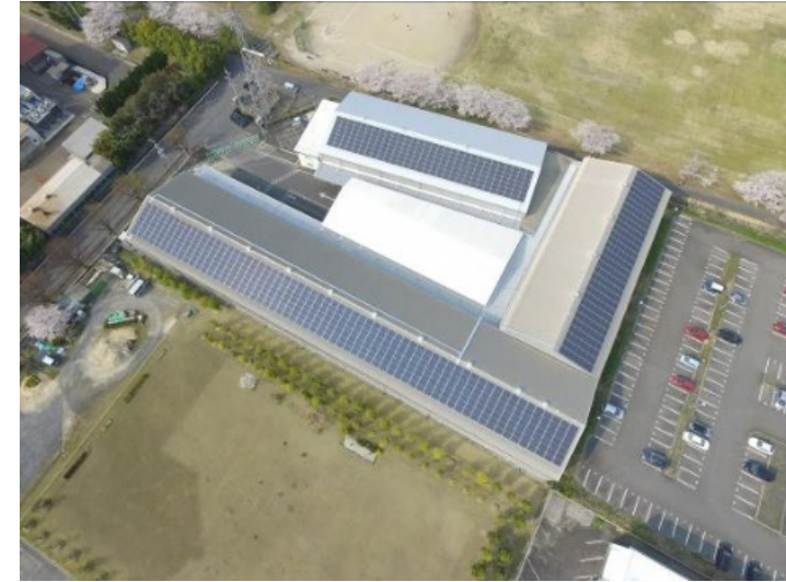
野洲川太陽光発電所 273kW
