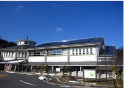
参考機 (16.3kw) 十二坊温泉ゆらら 発電所
