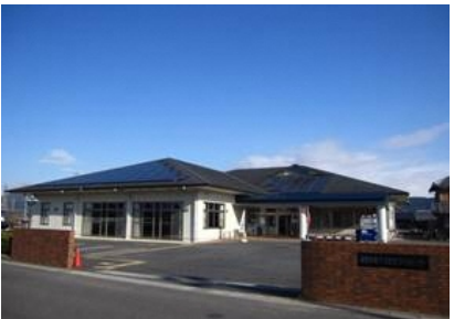
四号機 (23.6kw) 柑子袋まちづくり センター発電所
