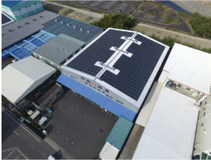
夏見東太陽光発電所 266kW
