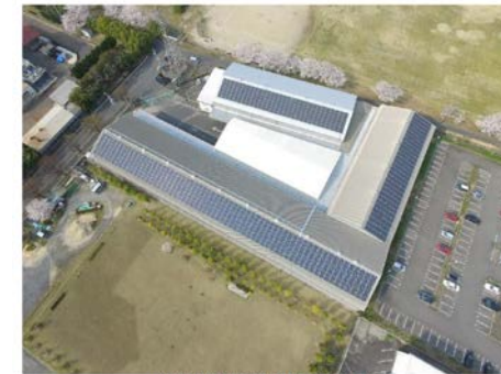
野洲川太陽光発電所
