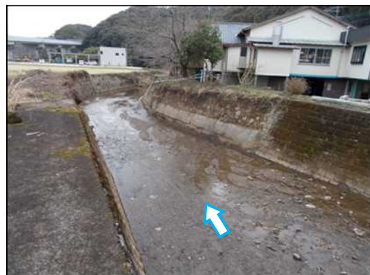
浚渫が完了した河川
