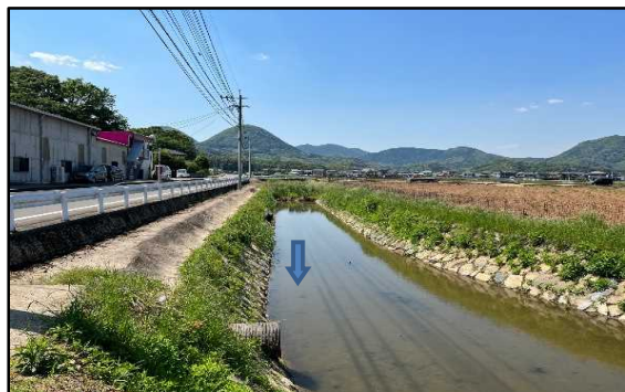
浚渫が完了した河川
