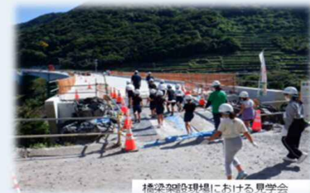
橋梁架設現場における見学会
