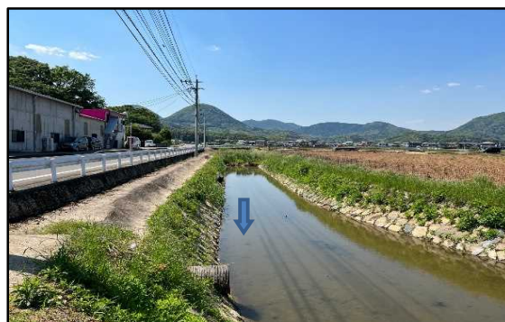
浚渫が完了した河川
