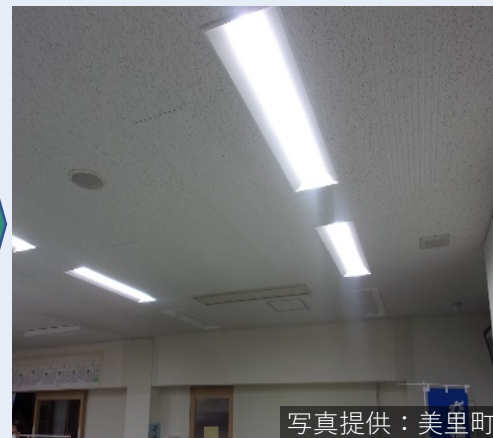
<蓄電池使用時>
