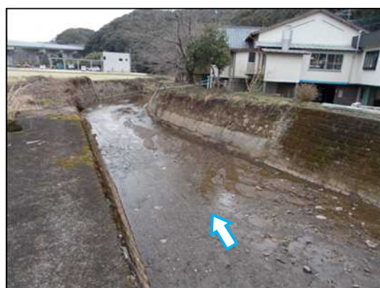
浚渫が完了した河川
