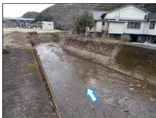
浚渫が完了した河川
