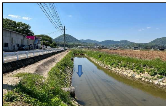
浚渫が完了した河川
