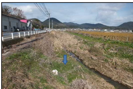
土砂が堆積した河川
