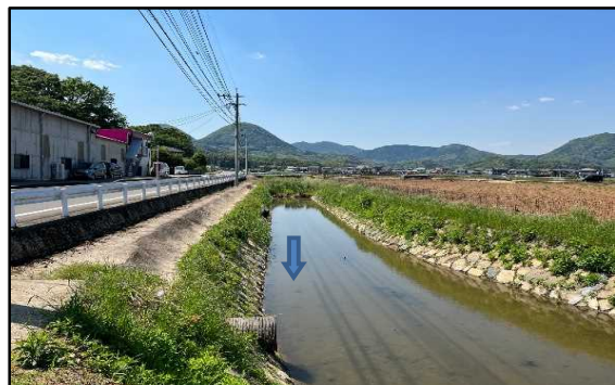
浚渫が完了した河川
