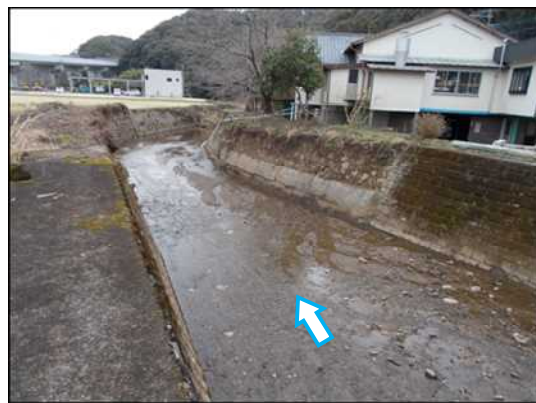
浚渫が完了した河川
