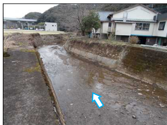
浚渫が完了した河川
