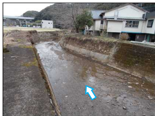
浚渫が完了した河川
