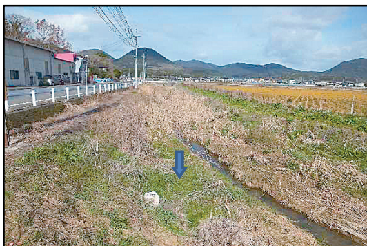
土砂が堆積した河川
