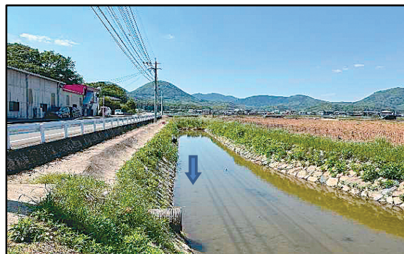
浚渫が完了した河川
