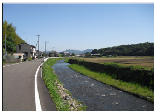
浚渫が完了した河川
